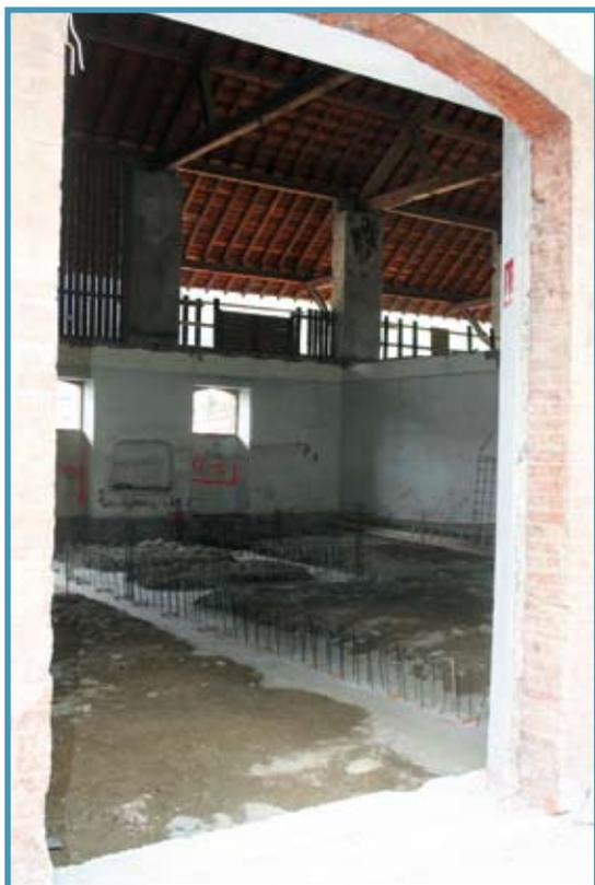
Actuellement les travaux de construction des murs intérieurs sont en cours pour le studio d'enregistrement, la chaufferie, les sanitaires communs au studio et la salle de répétition, l'escalier de secours. Les ouvertures supplémentaires sur la façade nord sont terminées.
