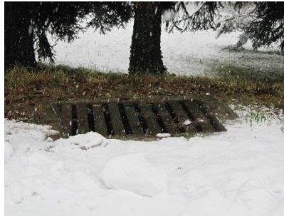
Grille pluviale Saint Claude Route du Pic
